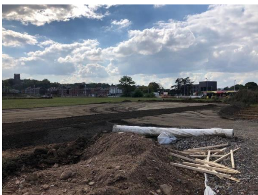
Apport des terres graves et pose du géotextile et empierrement
